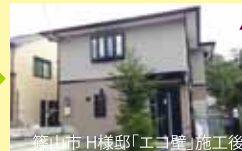
篠山市H様邸「エコ壁」施工後
